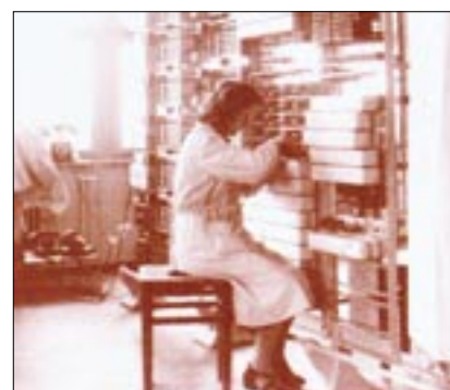
Slika 2. Predinstalacija telegrafске centrale tipa crossbar
