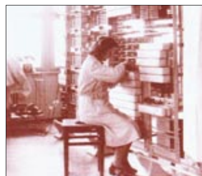
Рис. 2. Предварительный монтаж телеграфной станции типа crossbar
